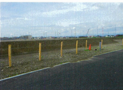
1.5mの盛土工事も終了
